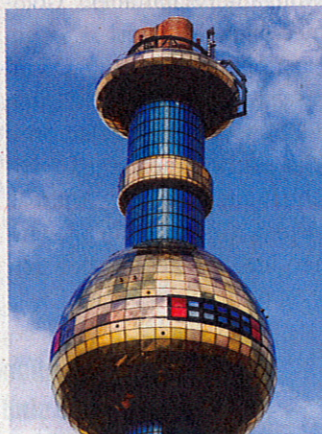
Die Müllverbrennungsanlage wurde auch lackiert
